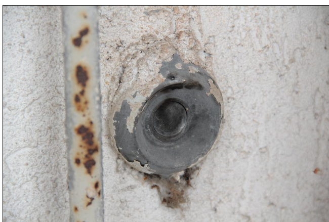
Foto 7 Zustand 2014, Original Signalschalter an der Süd-West Ecke (rechts neben dem Fenster)
