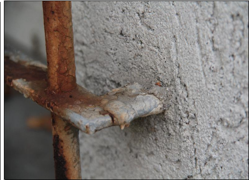
Foto 15 Originalverankerung der Fenstergitter
