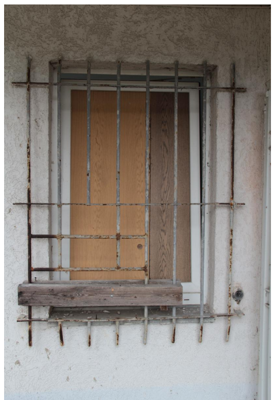
Foto 6 Zustand 2014, Original Fenstergitter mit Durchreichemöglichkeit an der Süd-West Ecke
